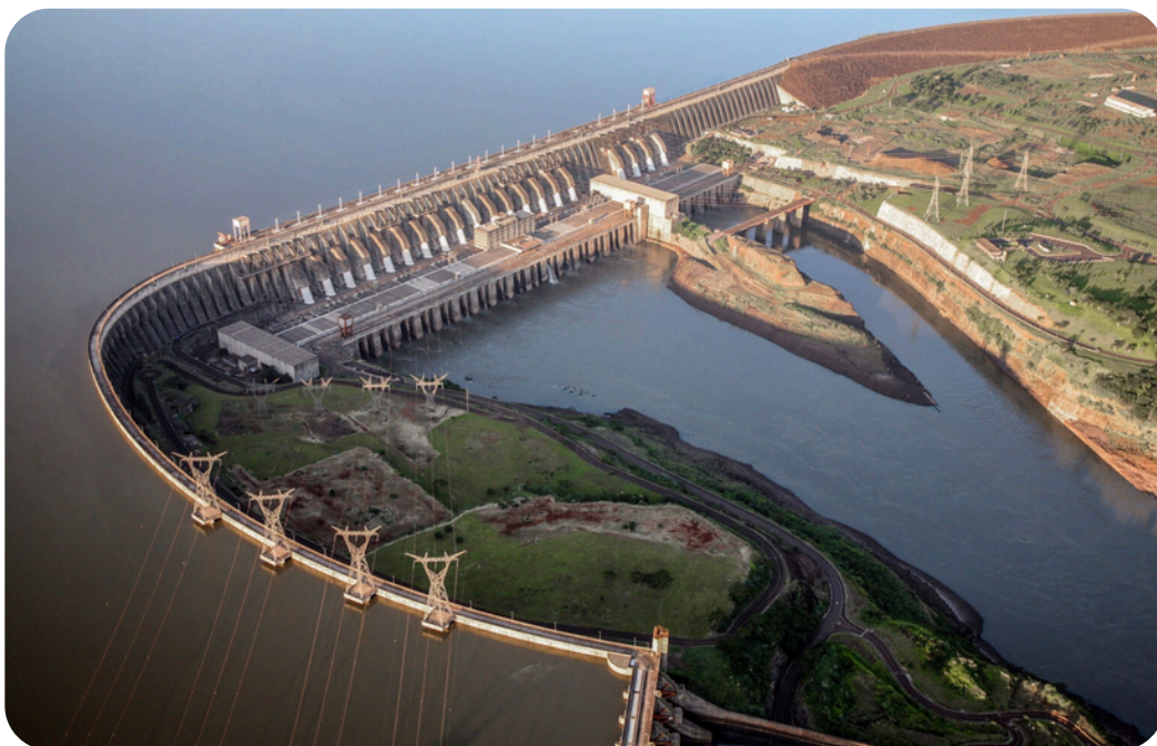
Usina hidrelétrica de Itaipu
